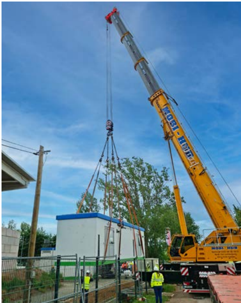
Logistische Meisterleistung für die Biogas-Einspeiseanlage in Weißenfels: Der 80-Tonnen-Verdichter wurde mit einem 450-Tonnen-Kran gehoben – angeliefert von drei 8-achsigen Tiefladern.
