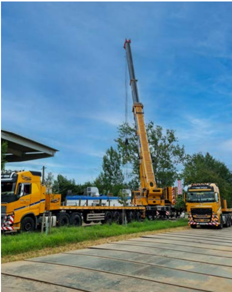
Logistische Meisterleistung für die Biogas-Einspeiseanlage in Weißenfels: Der 80-Tonnen-Verdichter wurde mit einem 450-Tonnen-Kran gehoben – angeliefert von drei 8-achsigen Tiefladern.
